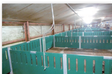
西日本原種豚場1-2舎改修
