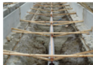
〇パイプを埋設
