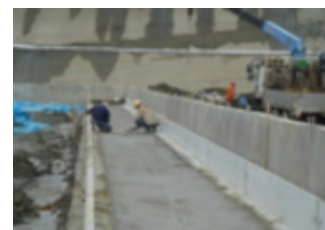
底部をコンクリートで形成
