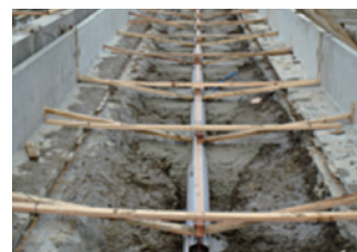
〇パイプを埋設
