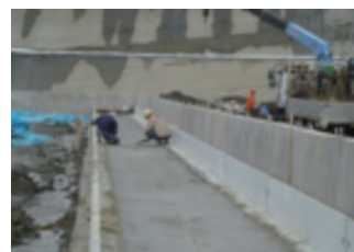
底部をコンクリートで形成
